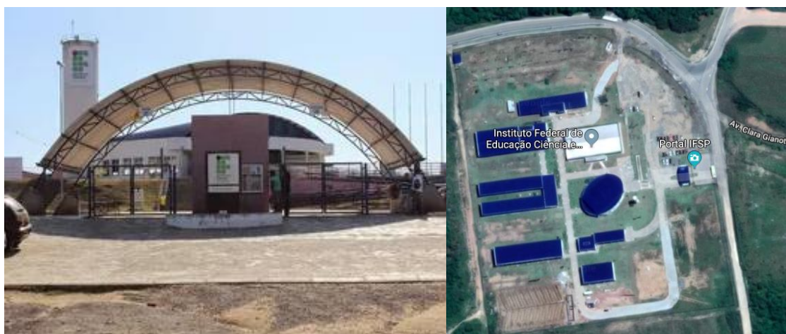
Figura 1 - Portal de entrada (à esquerda) e imagem aérea (à direita) do câmpus IFSP Registro em 2019
